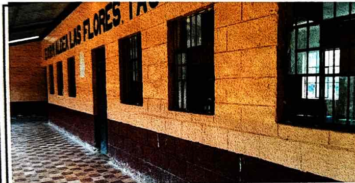
Foto 3: Sustitución de ventanas por deterioro.
