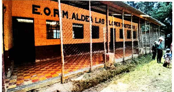
Foto 2: Sustitución de cerco lado frontal.
