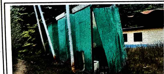
Foto 5: Sustitución de baño y accesorio por deterioro.
